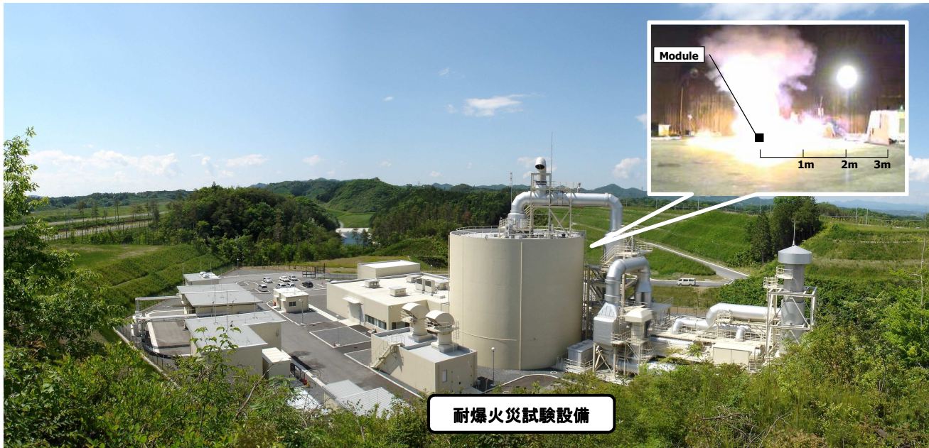
耐爆火災試験設備
